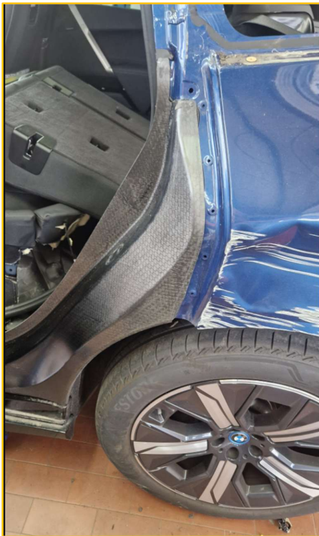
Bild 1: Werkstattbild Unfallschaden Seitenwand h.l.
